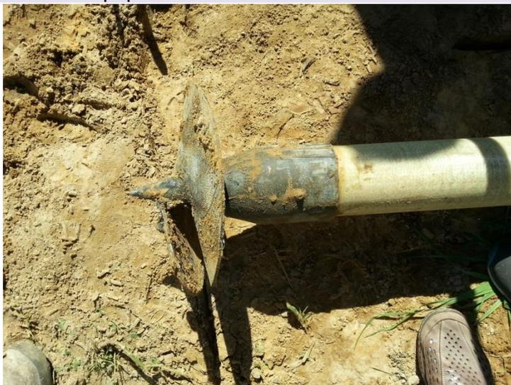
Рисунок 5. Композиционная винтовая свая
