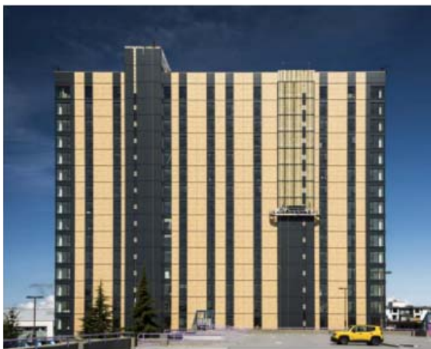
Fig. 1. Brock Commons Tallwood House
