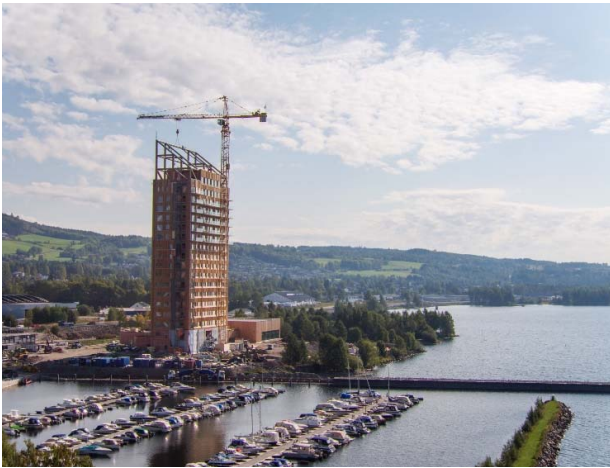
Fig. 3. Mjøstårnet Tower, Norway
