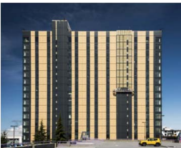
Fig. 1. Brock Commons Tallwood House
