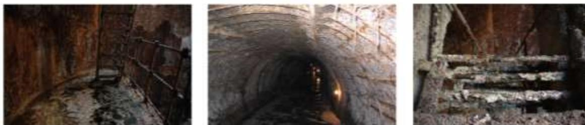
Рисунок 1 – Канализационные шахты и коллекторы в Санкт-Петербурге, подвергнутые разрушению
