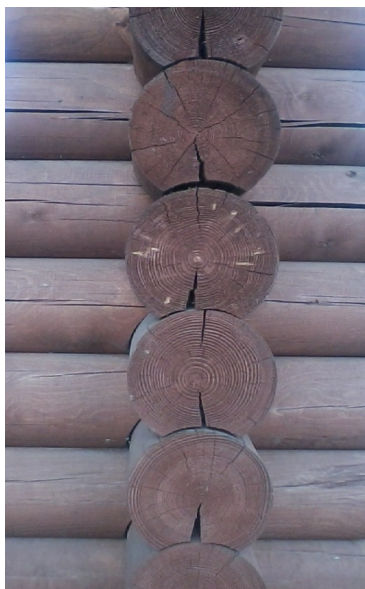
Рисунок 1. Трещина на поверхности технологического желоба
